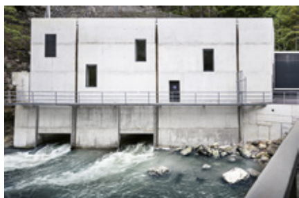
Centrale hydroélectrique de Rondchâtel-Péry
